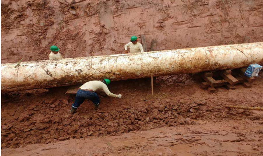
Gráfico N° 5 – Excavación manual para liberar la tubería.
