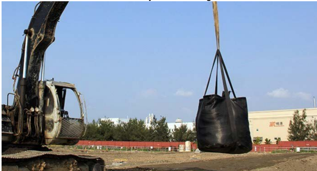
Gráfico N° 24 – Izaje de bolsa de geotextil.
