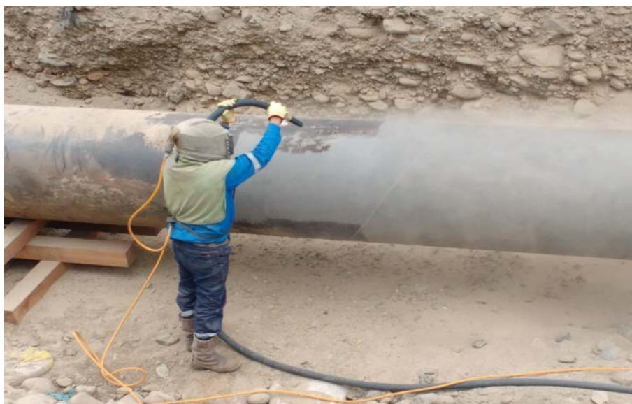
Gráfico N° 9 – Proceso de Arenado a Metal Blanco.
