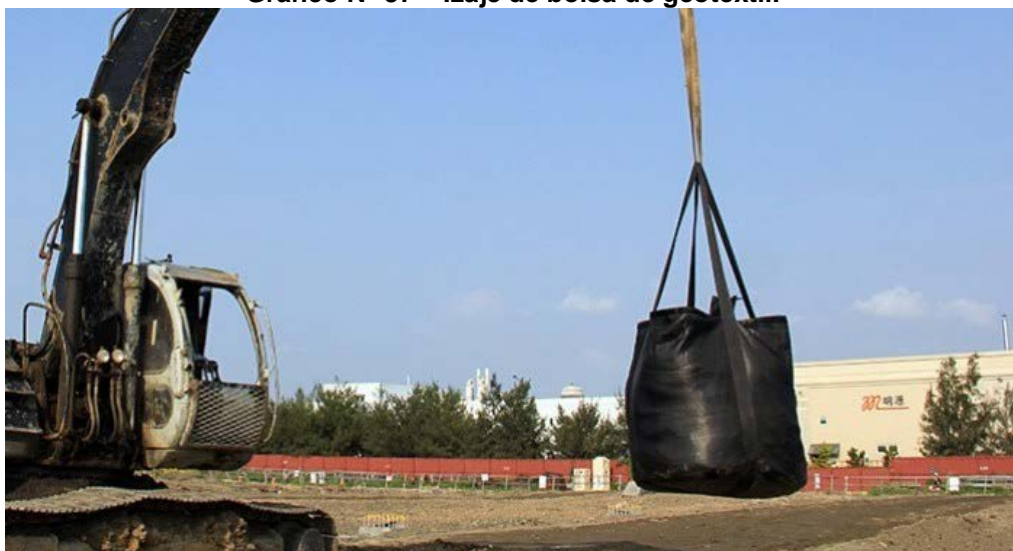
Gráfico N° 37 – Izaje de bolsa de geotextil.
