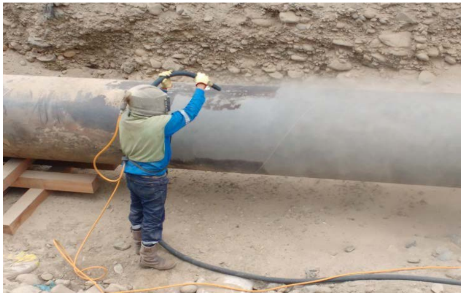
Gráfico N° 9 – Proceso de Arenado a Metal Blanco.
