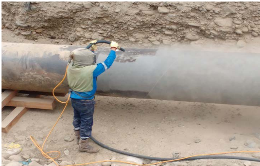
Gráfico N° 9 – Proceso de Arenado a Metal Blanco.
