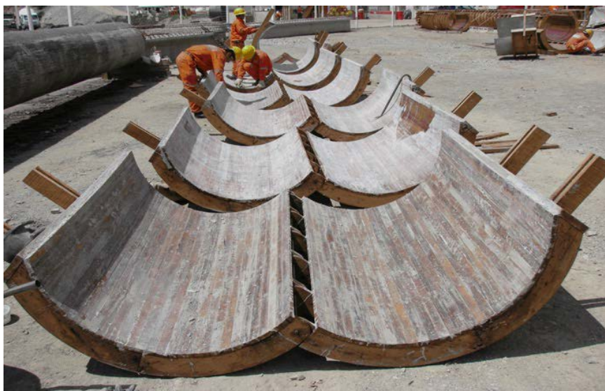
Gráfico N° 11 – Moldes de encofrado curvo.
