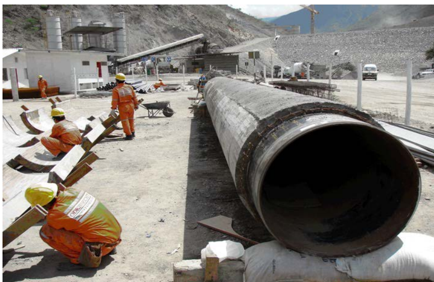
Gráfico N° 14 – Anillo de protección terminado.
