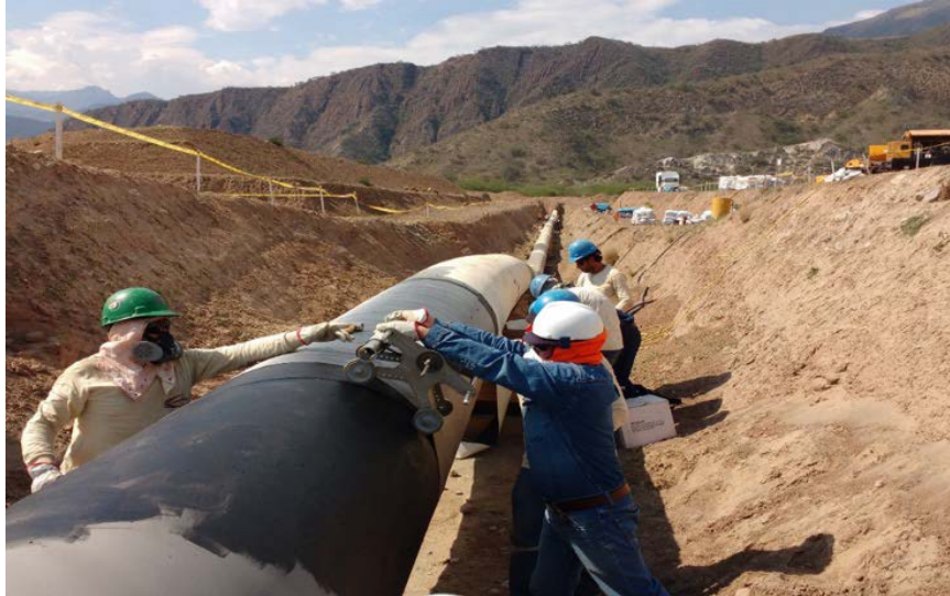
Gráfico N° 10 – Colocación de Polyguard.
