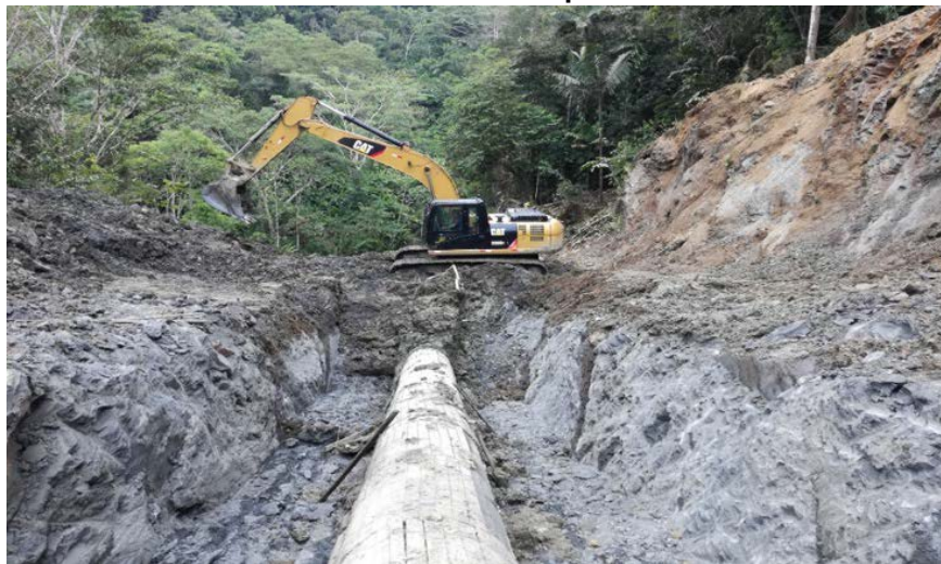
Gráfico N° 3 – Excavación con maquinaria de tubería ONP.
