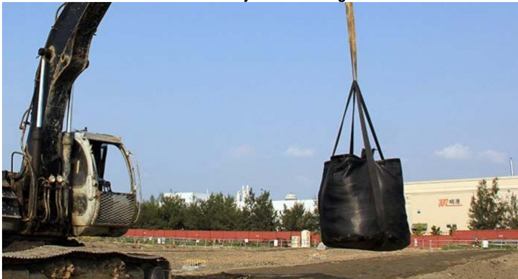
Gráfico N° 25 – Izaje de bolsa de geotextil.
