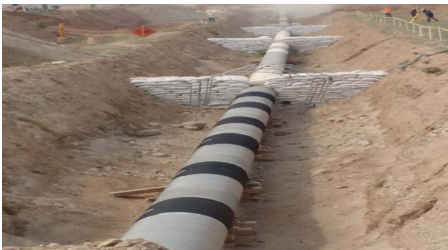
Gráfico N° 15 – Anillo de protección terminado.
