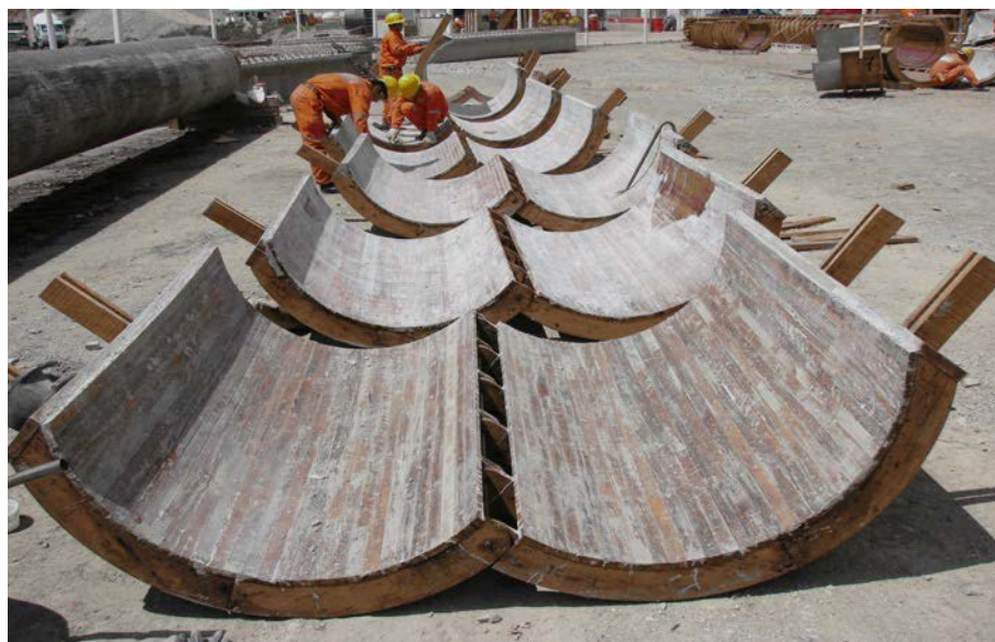
Gráfico N° 11 – Moldes de encofrado curvo.
