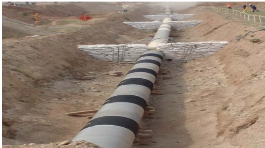
Gráfico N° 15 – Anillo de protección terminado.
