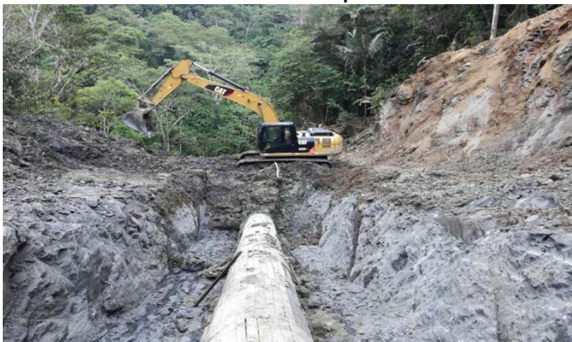
Gráfico N° 3 – Excavación con maquinaria de tubería ONP.
