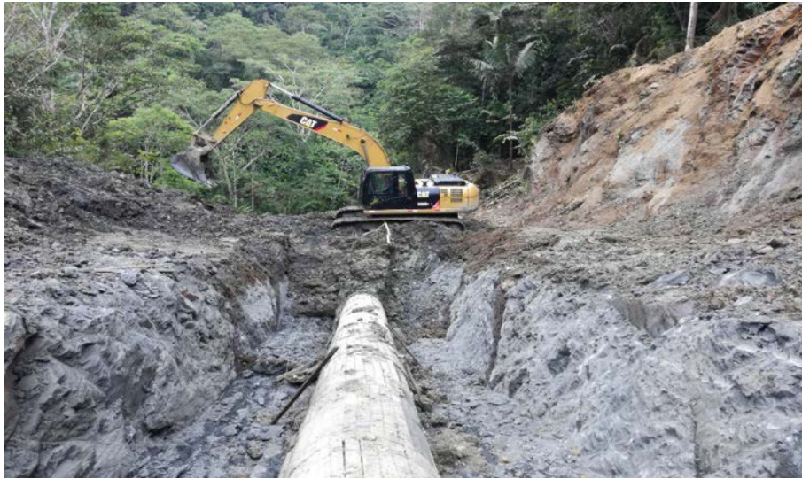
Gráfico N° 3 – Excavación con maquinaria de tubería ONP.
