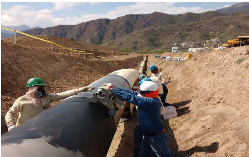
Gráfico N° 10 – Colocación de Polyguard.
