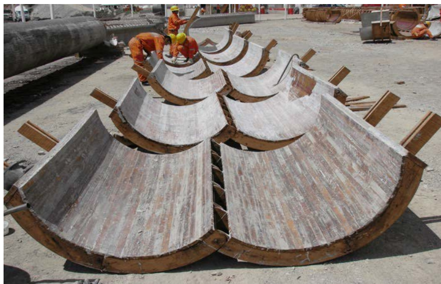
Gráfico N° 11 – Moldes de encofrado curvo.
