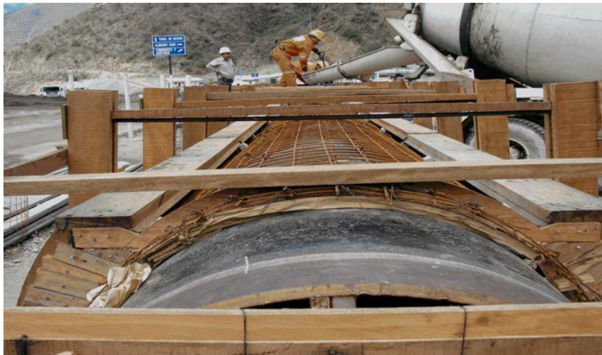
Gráfico N° 13 – Vaciado de concreto para anillo de protección.
