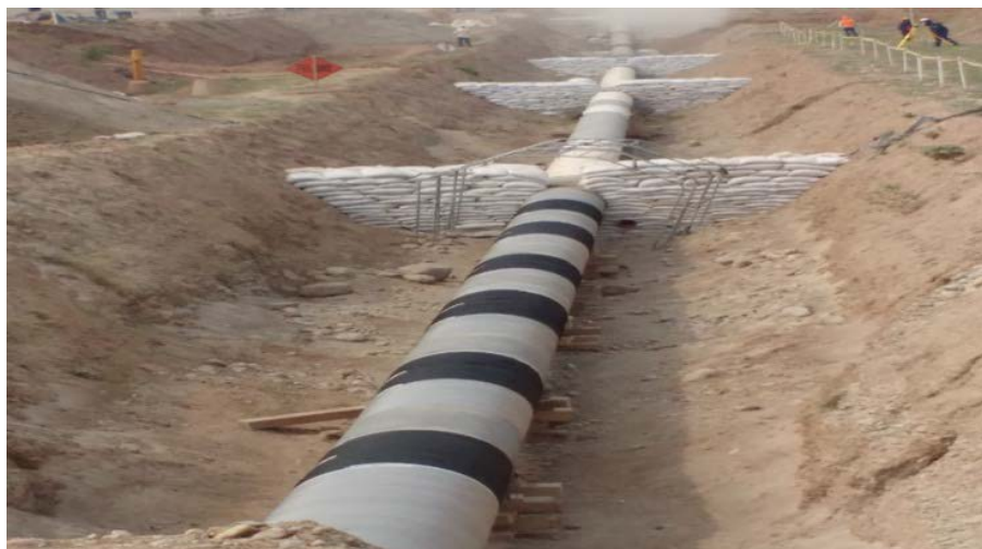
Gráfico N° 15 – Anillo de protección terminado.
