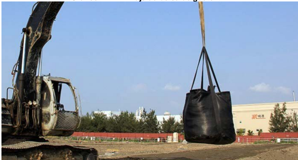
Gráfico N° 21 – Izaje de bolsa de geotextil.
