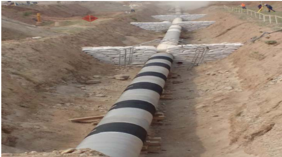
Gráfico N° 11 – Anillo de protección terminado.
